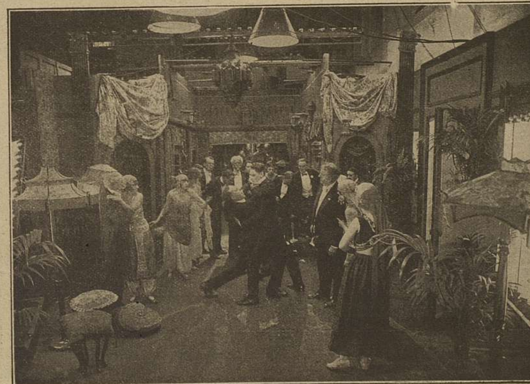
Photo prise dans un studio américain pendant une scène de prise de vues. On peut voir les appareils d'éclairage et de quelle manière sont fixés les décors qui s'arrêtent à la limite du « champ » de l'appareil de prise de vues.
