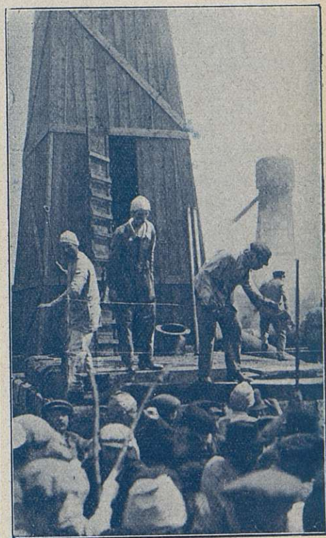
Les ouvriers sortant d'un des puits en flammes.
