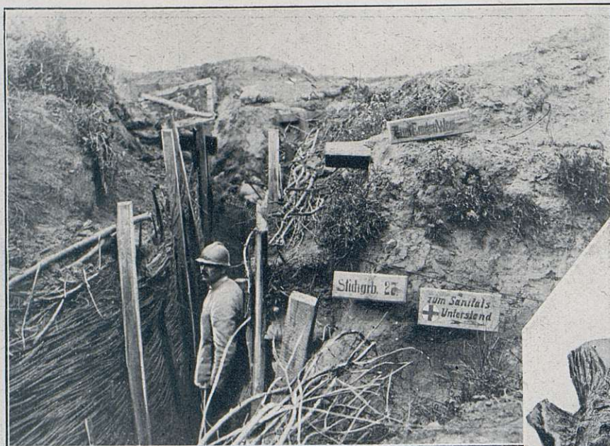
Une tranchée allemande reconquise
