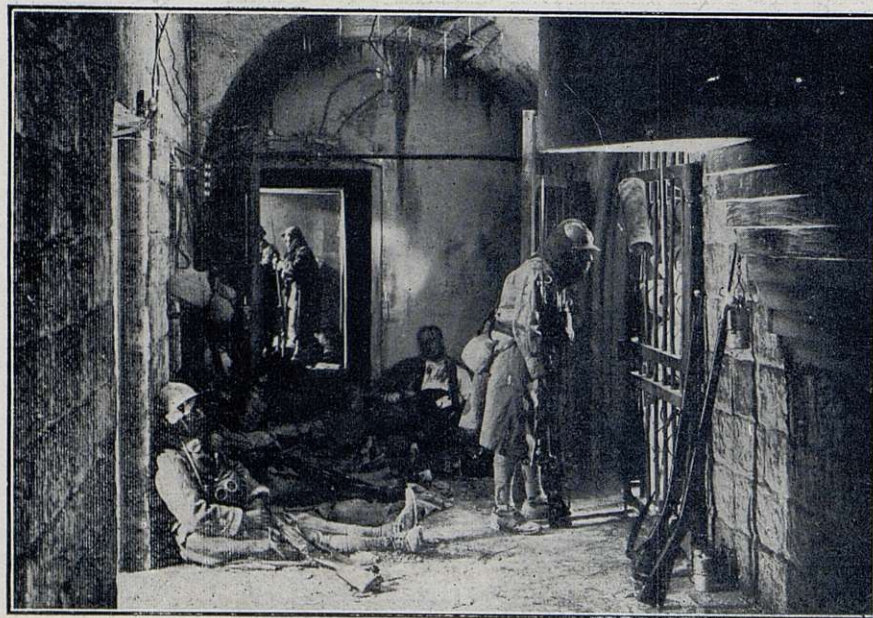
Dans les souterrains du fort de Vaux.
