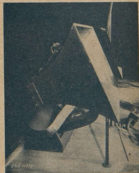
Deux des quatre grands haut-parleurs qui se trouvent derrière l'écran pour l'amplification des sons dans le procédé Vitaphone.
