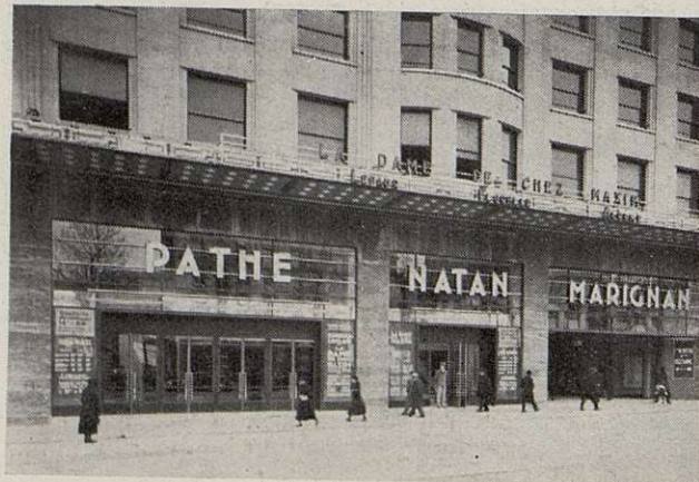
La façade simple, large et éclairée du cinéma, avec l'entrée du passage Marignan, à droite. De gros projecteurs placés face au bâtiment font du Marignan, la nuit, une tache lumineuse visible dans toute l'avenue des Champs-Élysées.
