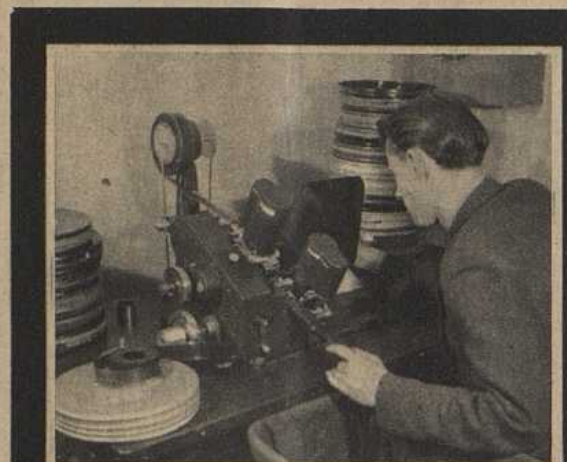
Au moyen d'une moviola, le monteur choisit et découpe les scènes les plus intéressantes.
