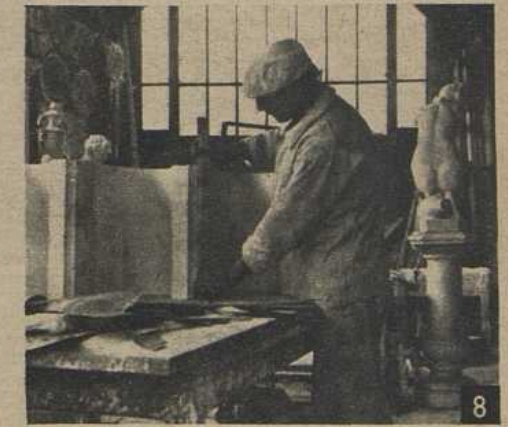
ATELIER DE STAFF. — C'est ici que sont moulés certains éléments de décor. Peint, le staff (plâtre coulé sur un support en filasse ou en bois) donne l'illusion parfaite des matériaux d'architecture.
