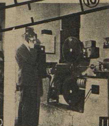
ENREGISTREMENT DU SON. — Dans une étroite cabine voisine du plateau, l'opérateur du son module les bruits et les paroles captés par le microphone et qui iront s'inscrire sur une pellicule spéciale placée dans un appareil-enregistreur.
