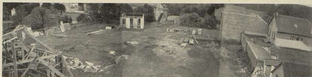
7 juin : les arbustes sont arrachés, le terrain nivelé.
