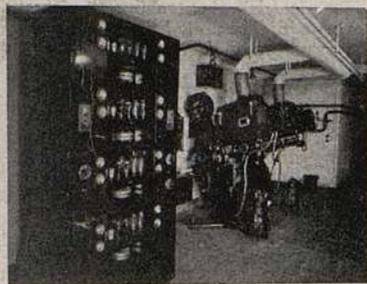
Meuble d'amplification "double-channel", 40 W modulés. (Photo Radio-Cinéma.)
