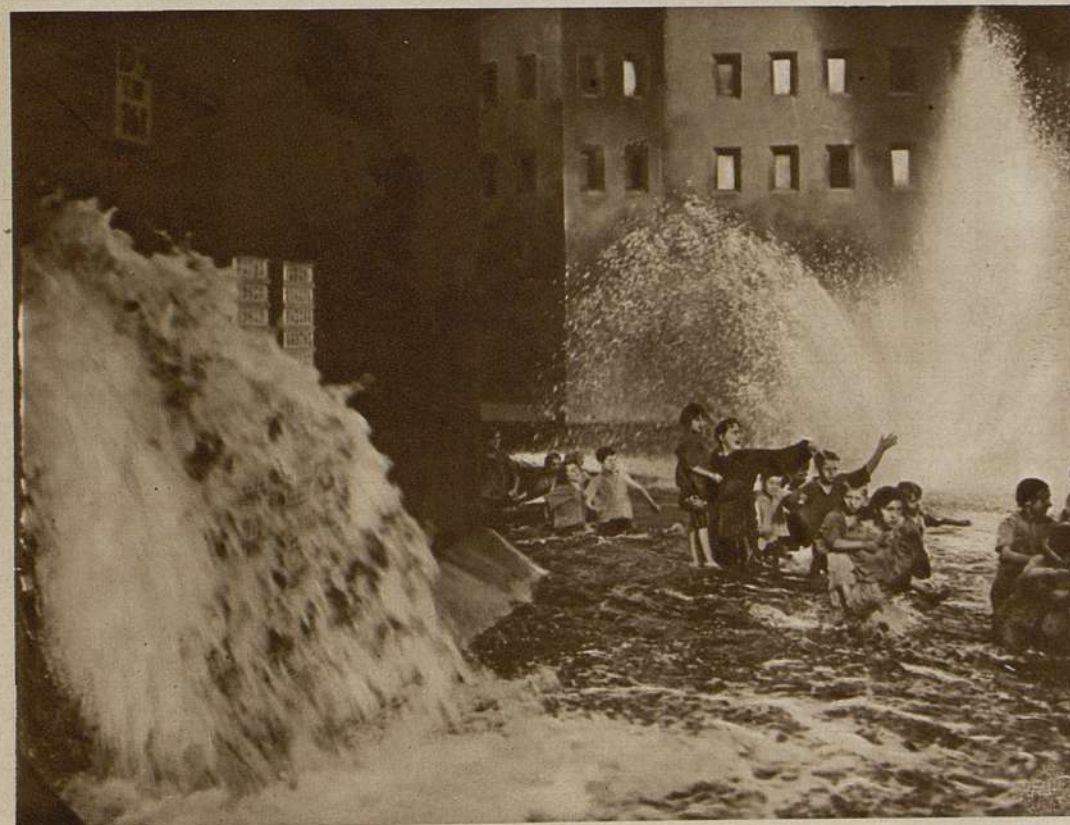
L'inondation dans les galeries souterraines de la cité ouvrière.
