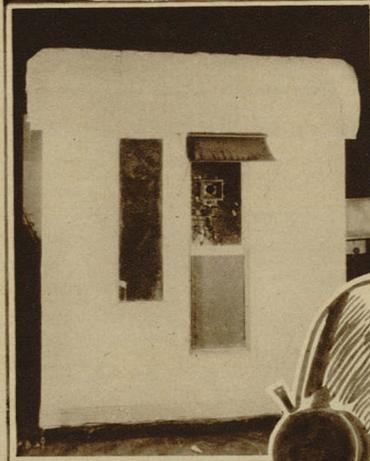
Cabine de prises de vues pour films parlants, aux studios Universal. La camera opère au travers d'une double plaque de verre. Le "réfrigérant" empêche le bruit de la camera de parvenir jusqu'au microphone.
